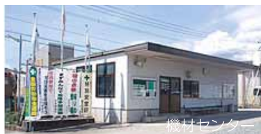
機材センター
