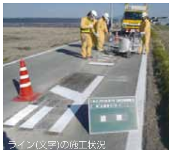
ライン(文字)の施工状況
