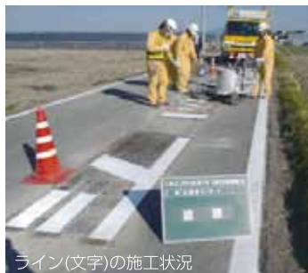
ライン(文字)の施工状況
